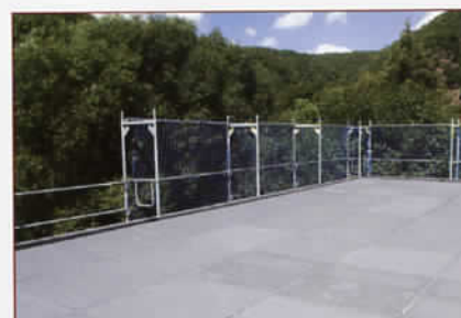
Isolamento di tetti piani con Neopor.
