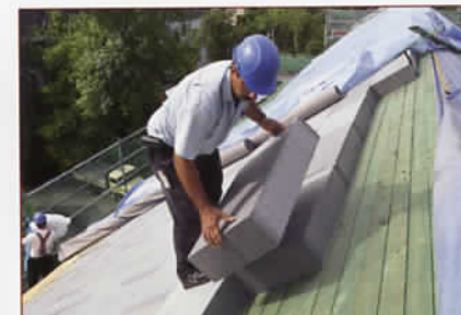
Isolamento di tetti a falda con Neopor.
