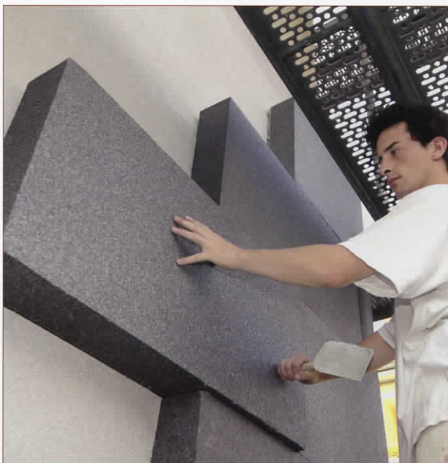
L'impiego della colla in quantità prescritte dal produttore garantisce una tenuta sicura delle lastre.
