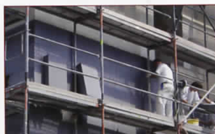
Isolamento a cappotto esterno con lastre in Neopor (ETICS).
