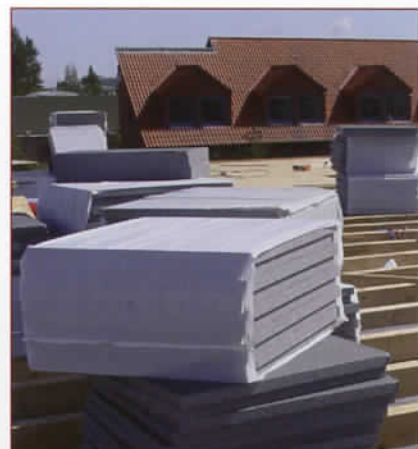
Pacchi di lastre isolanti in Neopor® confezionate con pellicola opaca, stoccate all'aperto.
